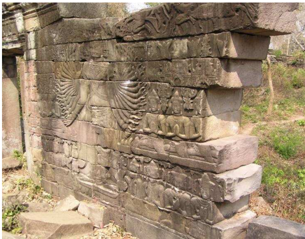
Pl. 100. Bantéay Chmàr Lokeśvara wall dismantled 02.04
